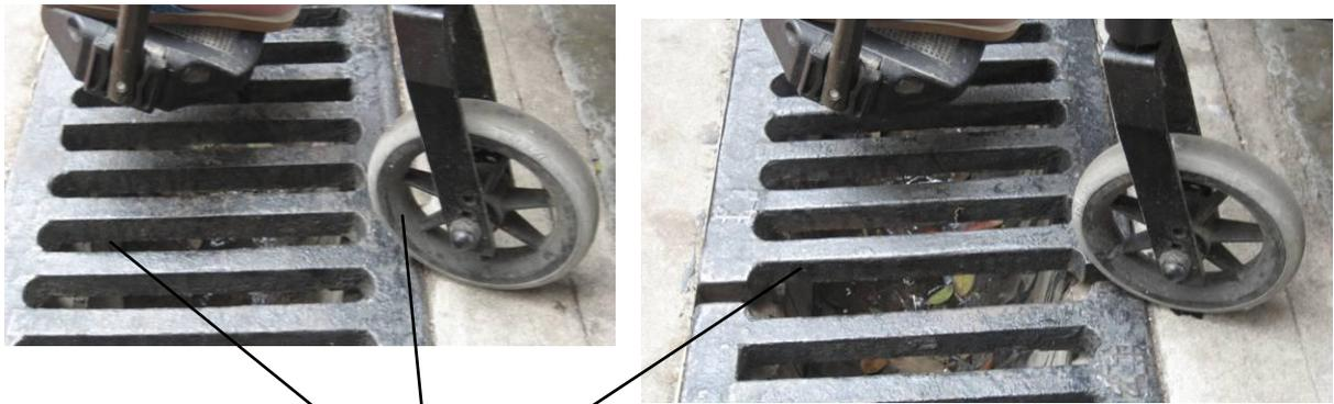
輪椅的前輪與水渠蓋隙位闊度相約 (圖片攝於 2007 年 3 月 8 日)
